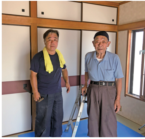
息の合った作業で工事を進める吉川さん父子
