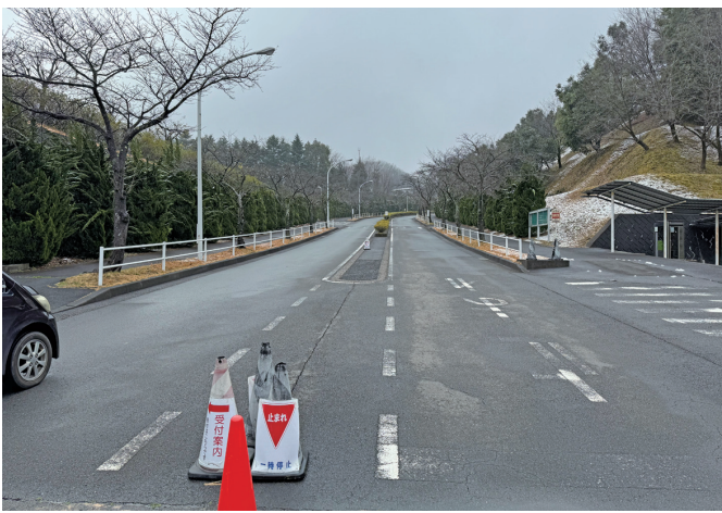
日本航空高校石川などが移転する明星大青梅校。現在は工事車両以外は正門で通行止めとなっている
