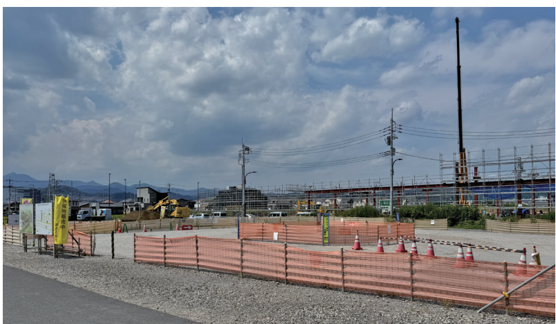
整備が進む武蔵引田駅北口の区画整理地区。秋留台地域総合整備計画のミニ版とも言えそうだ
